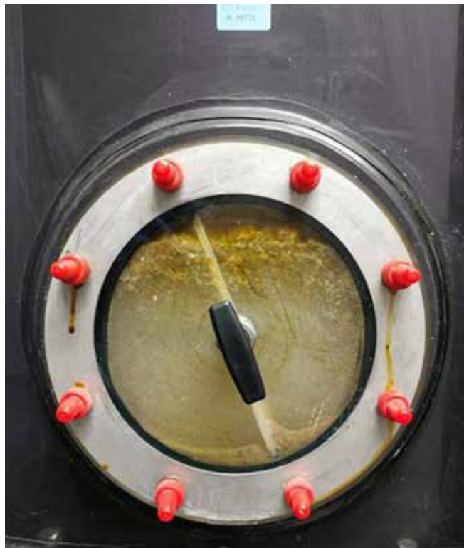
Prüffenster Fettabscheider
